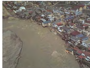
台風の影響で基礎の土砂を半分割り取られても、建物本体は原形を保ったミサワホームの建物
