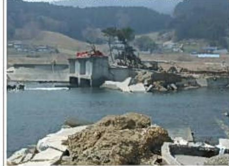
上屋の流失した水門と引き波で倒壊したと考えられる防潮堤
