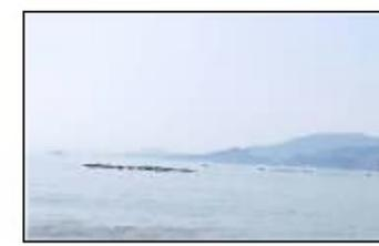
離岸堤2基のうち東側の1基は天端が多少沈下したものの残存している
