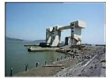
水門本体(ゲート・門柱)は杭式構造のため残存したものと推察される。ゲート操作は不能。痕跡高はT.P.+11.1m。
