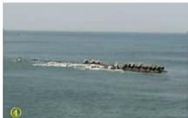
離岸堤の一部が被災し、破壊もしくは流出している（写真④）。
