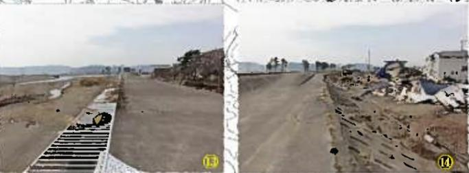
久慈湊漁港海岸の久慈川左岸の裏のりは津波の越流により損壊が見られる。表側には損壊はない。背後地の家屋の損傷は一部全壊もあるが、その範囲は広くない。(写真⑪-⑭)
