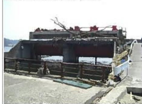
引き波による土砂流失が原因で倒壊したと考えられる
