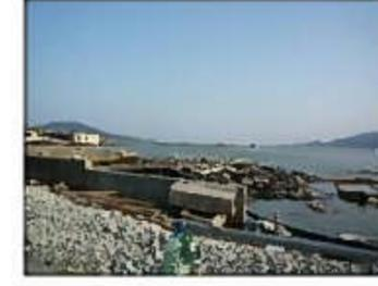
防潮堤の決壊により古川沼に海水が流入し、国道45号線が高潮等で冠水する可能性があるため、応急復旧が必要。
