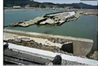
橋梁アバット部両端の河川堤防が破堤し、海水の流入あり。連絡盛土部からの越流及び橋台周辺での乱流により、背後が洗掘され被災したと推察される。
