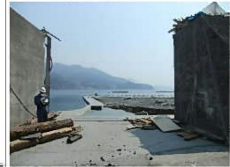
引き波により陸側の扉体が流失し、水流の集中により防潮堤が洗掘被災した可能性が考えられる。
