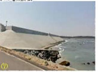
防潮堤の表・裏のり、前面の根固工ともに破損は見られない（写真⑦～⑪）。
