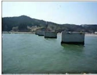
津波の水平力と揚圧力によるものと推察される。
