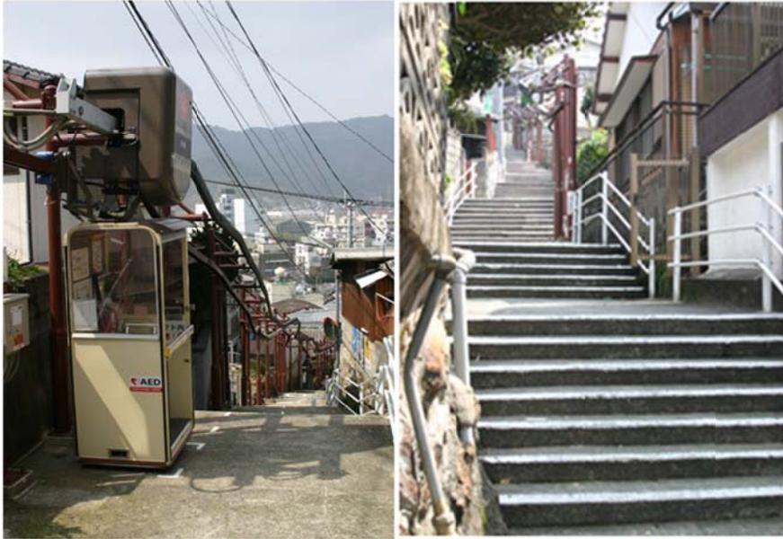
図-15 斜面移動機器：懸垂式（吊り下げ式）のミニモノレール型
