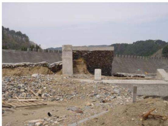
防波堤：倒壊した盛土とコンクリート版
