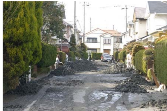
液状化による噴砂(千葉県浦安市)
