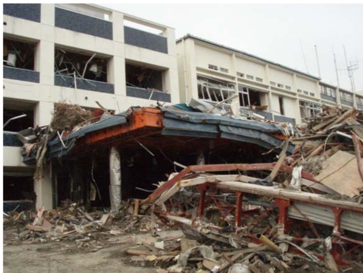
陸前高田市役所の被災状況 (出典)内閣府撮影
