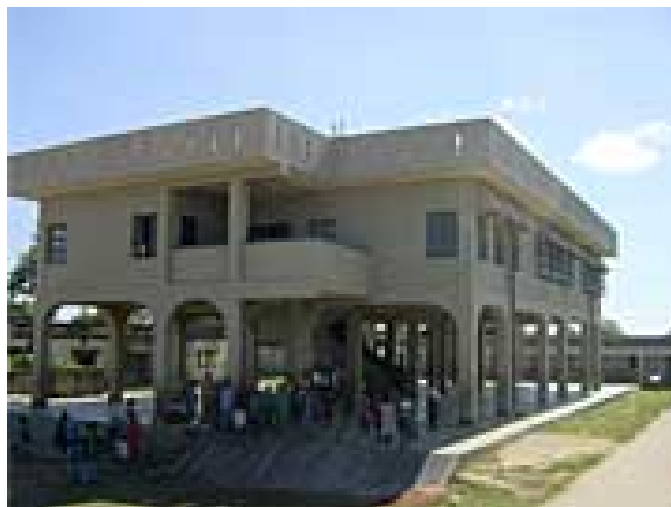
図表 2-2-4 多目的サイクロンシェルター（平時は小学校として利用）
