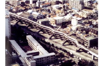
図 兵庫県南部地震被災状況
