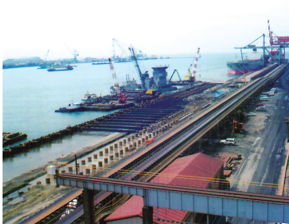
神戸製鋼所の加古川製鉄所 東岸壁復旧状況
