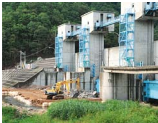
応急復旧の工事が行われている普代水門
