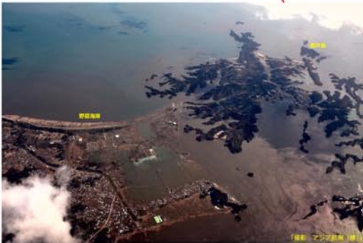
東松島市野蒜海岸周辺の被災状況
