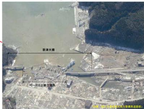
国道45号歌津大橋
