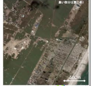
被災後（平成23年3月12日撮影）
