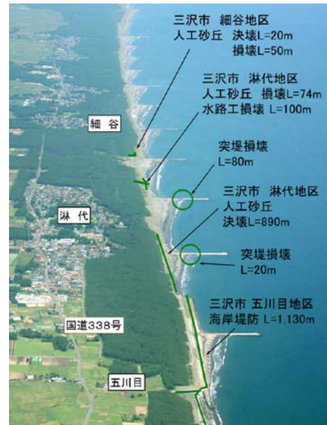
海岸防災林(三沢市)
