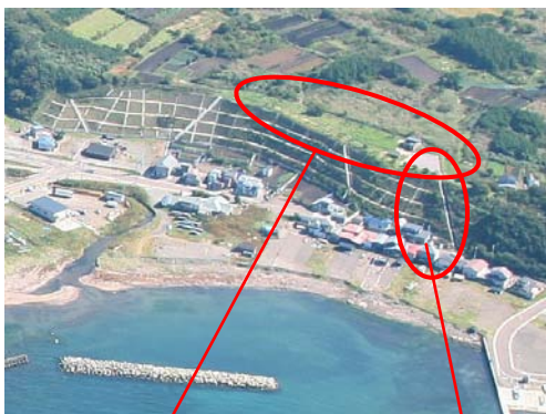
沿岸部集落の急傾斜地対策、高台避難の例
