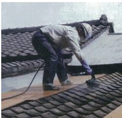
図-2-6：屋根の瓦除染の例 （吸引・高圧洗浄）
