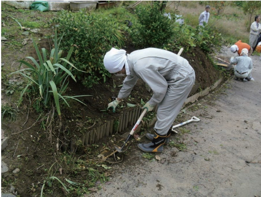
図-2-12：庭等の除染の例（下草等の除去）
