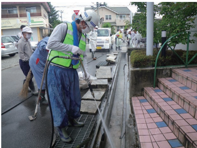
図-2-9：側溝の高圧水除染の例
