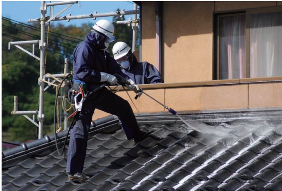
図-2-5：屋根の瓦除染の例（高圧洗浄）
