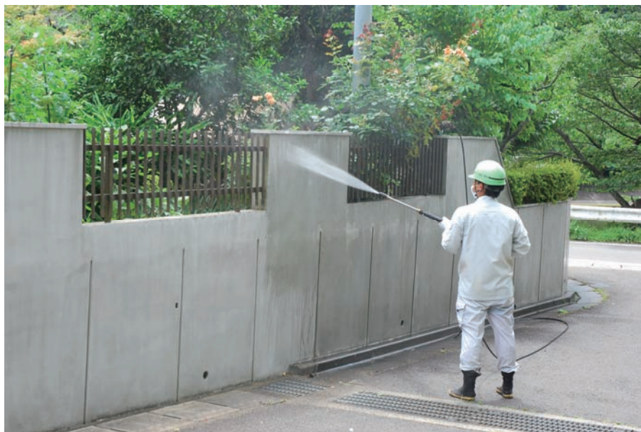
図-2-11：外塀の除染の例（高圧洗浄）
