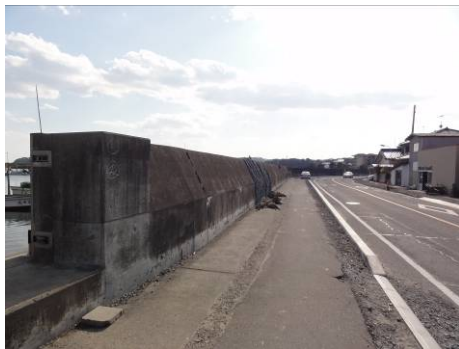
■ 磯崎漁港の防潮堤の景観
