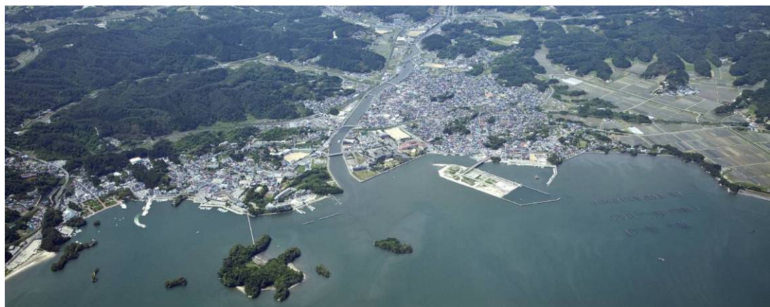
■被災後の松島湾（H23年6月9日撮影）
