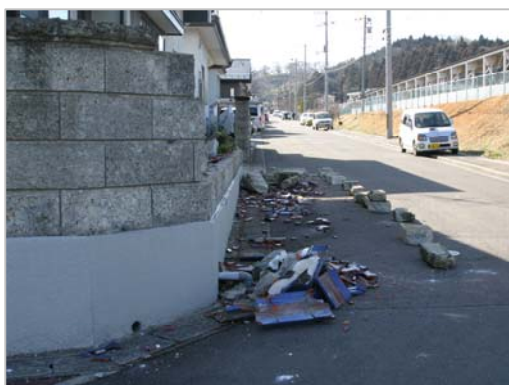
【住宅（ブロック塀）の倒壊】
