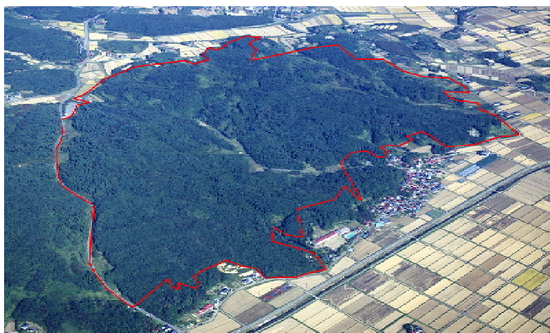
環境影響調査が進む 西部第一工業団地予定地 (郡山市熱海町上伊豆島周辺)
