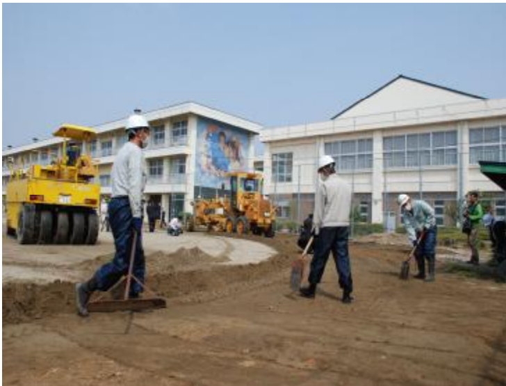
小学校の表土除去作業
