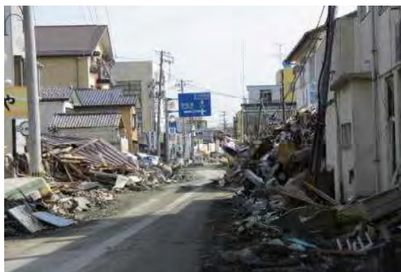
松川地区被災状況(H23.3.24)
