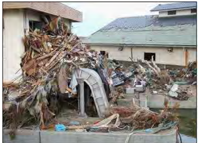
被災した芹谷地排水機場(H23.3.12)
