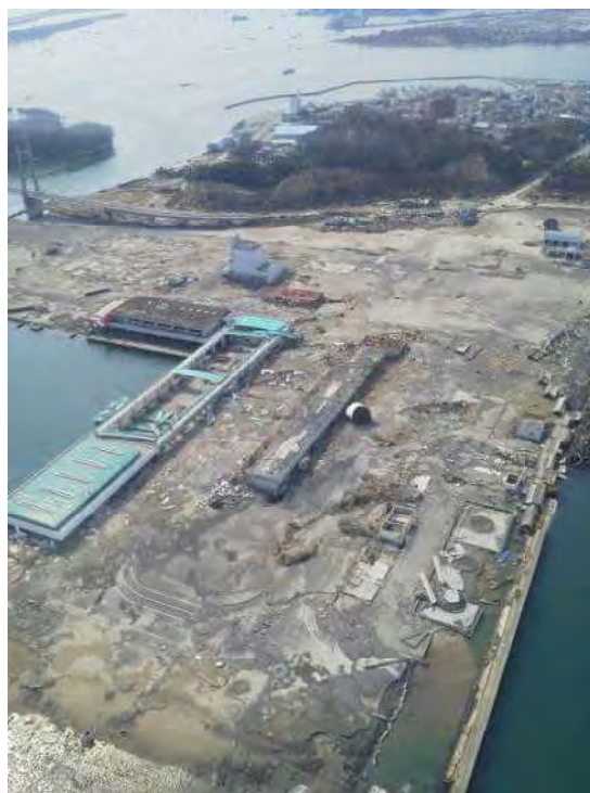
被災した松川浦漁港(H23.3.25)
