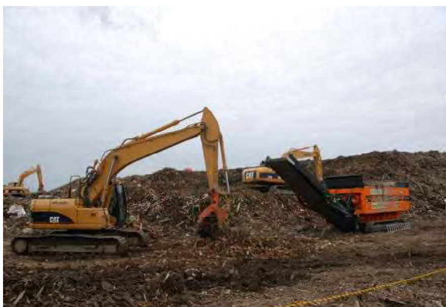
ガレキ処理作業(H24.3.8)
