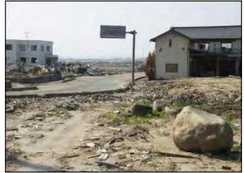
磯部地区道路復旧状況
